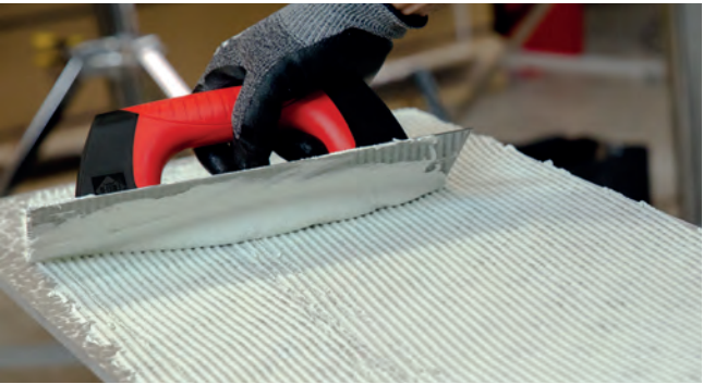
MAKE SURE THE THICKNESS OF THE LAYER OF ADHESIVE CEMENT IS UNIFORM · Asegúrate de que el grosor de la capa de cola sea uniforme · Veiller à ce que l'épaisseur de la couche de colle soit uniforme · Vergewissern Sie sich, dass die Kleberschicht gleichmäßig ist
