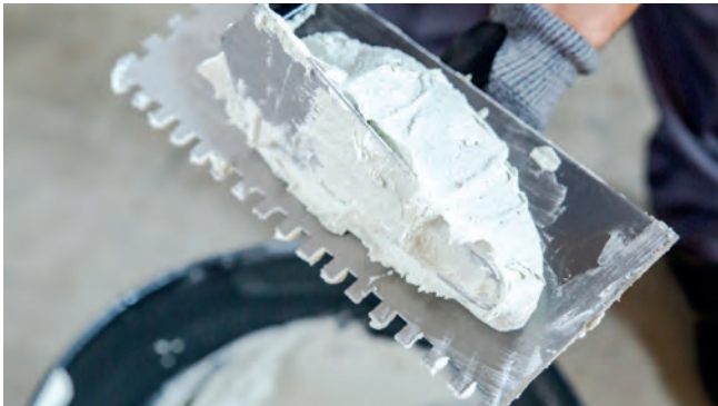
SPREAD THE ADHESIVE CEMENT WITH A TOOTHED TROWEL · Extiende el cemento de agarre con una llanta dentada · Étendre le ciment à prise rapide à l'aide d'une spatule dentée · Verstreichen Sie den Klebemörtel mit einem Zahnsachtel
