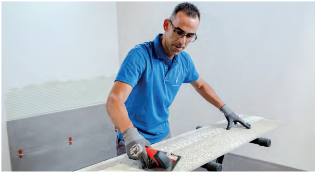
SPREAD THE ADHESIVE CEMENT WITH A TOOTHED TROWEL ON THE TILE · Extiende el cemento de agarre con una llanta dentada sobre la pieza · Étendre le ciment à prise rapide à l'aide d'une spatule dentée sur la pièce · Verstreichen Sie den Klebemörtel mit einem Zahnsachtel auf der Fliese
