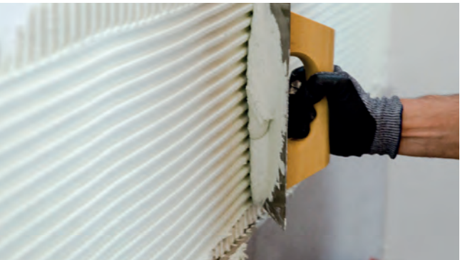
MAKE SURE THE THICKNESS OF THE LAYER OF ADHESIVE CEMENT IS UNIFORM · Asegúrate de que el grosor de la capa de cola sea uniforme · Veiller à ce que l'épaisseur de la couche de ciment colle soit uniforme · Vergewissern Sie sich, dass die Kleberschicht gleichmäßig ist
